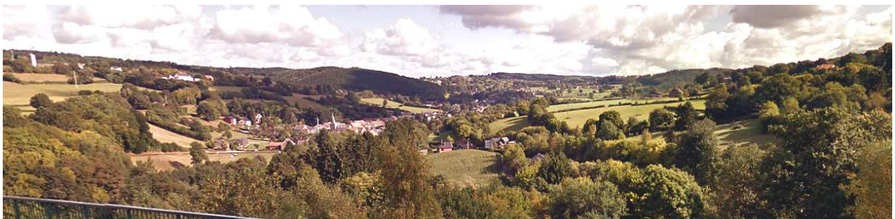
Du viaduc de Polleur
