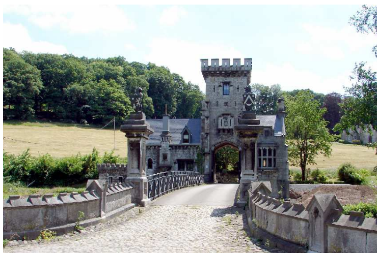
Porche d'entrée du parc du château
